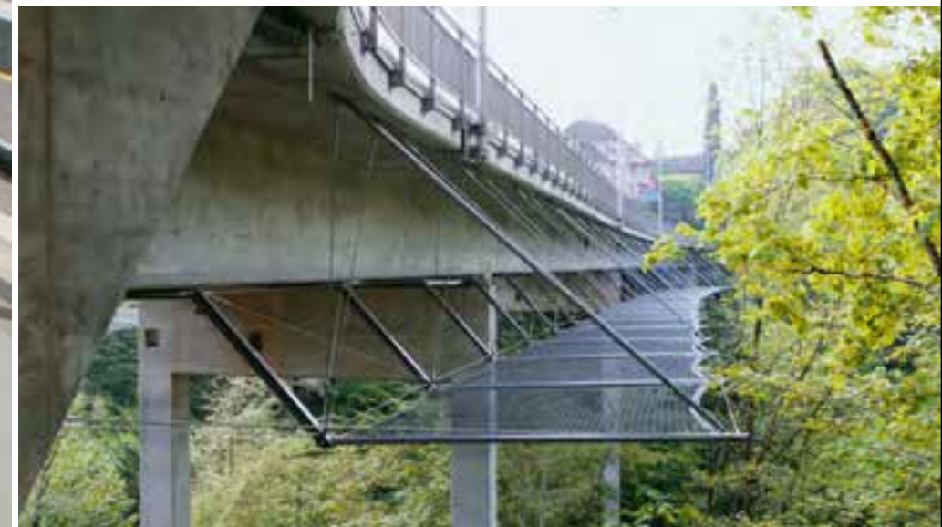
Rotbachbrücke, Rothenburg (CH)
